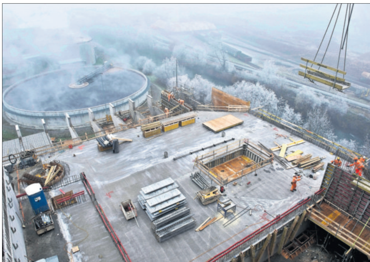
Die neue Kehrreichtverbrennungsanlage in Perlen wächst in die Höhe. 50 Meter hoch soll sie werden.
