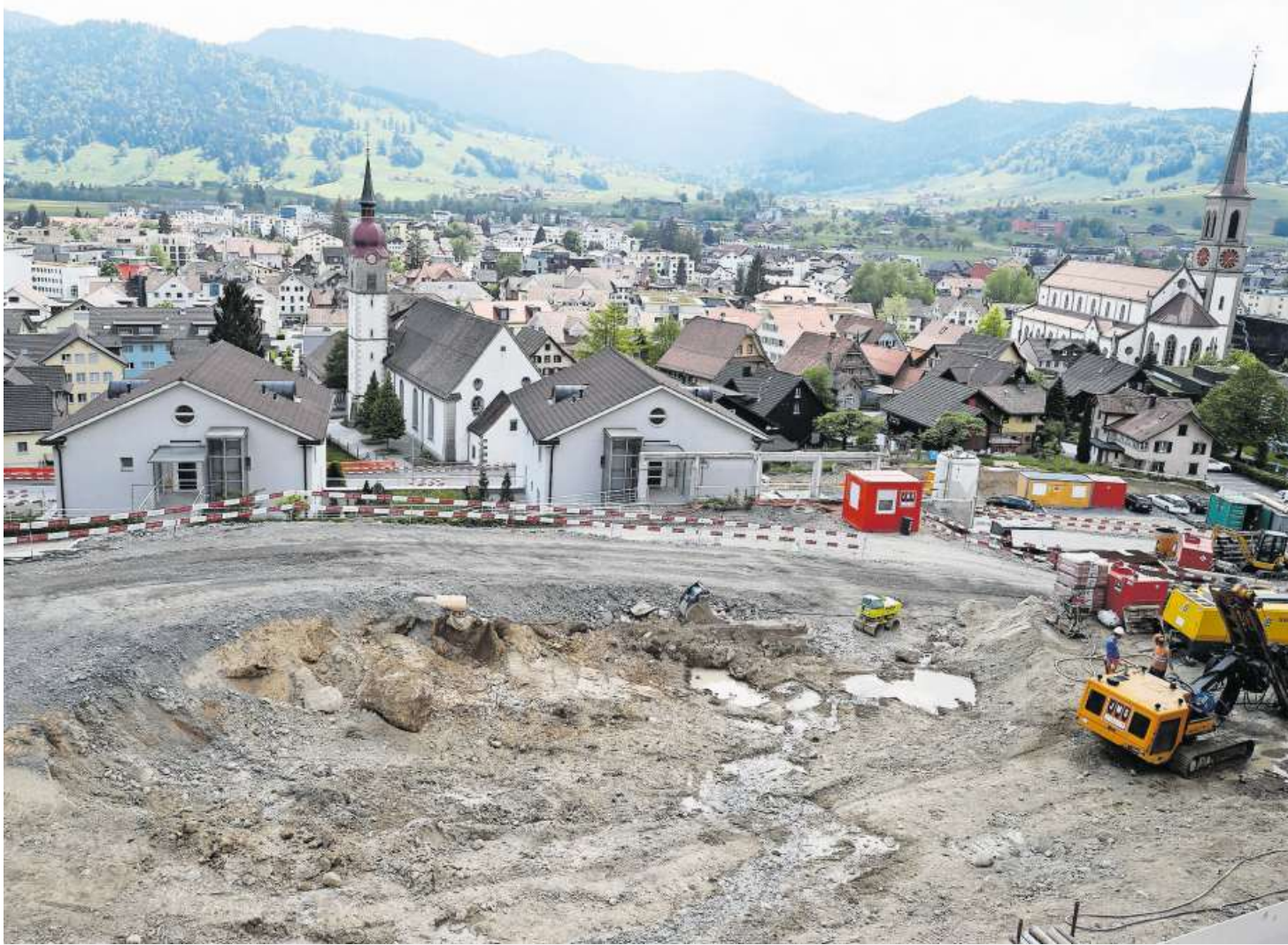
Das Bauprojekt «Am Baumgärtli» steht in der Kritik.
